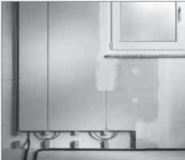
Система сухого панельного отопления стен с интегрированными трубами из полибутилена.
