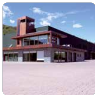
NEW PRODUCTION UNIT San Maurizio d'Opaglio (NO)
