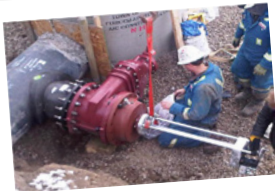
Канада - вредка под давлением отвода 28"x18" 28"x18" IPS EF Semeer Canlı Hat Bağlantısı
