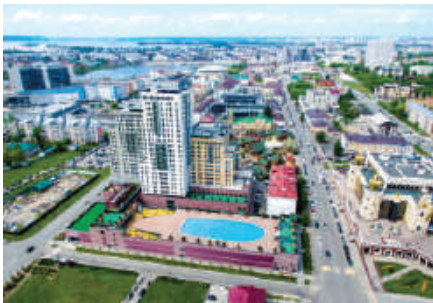
ЖК Барселона (г.Казань) 2016г.
